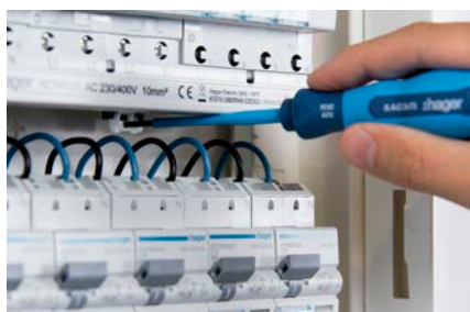
Povolte vybrané výrobky pomocí upevňovacích spon Quick-Snap
